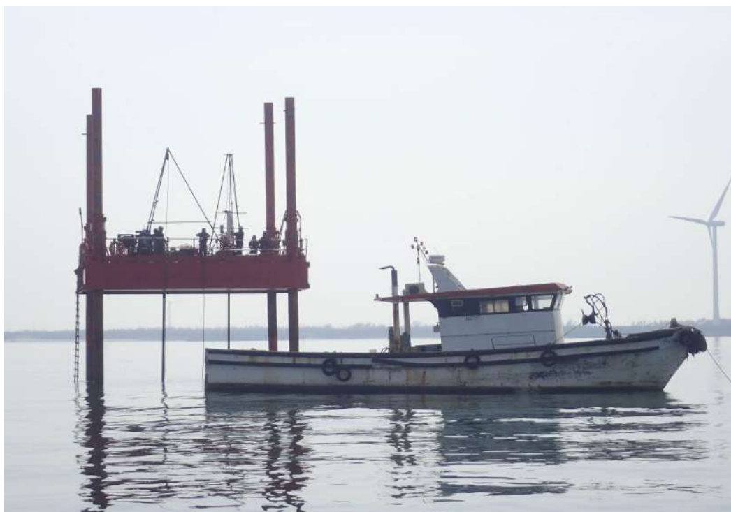
圖 4.2-1 5 月 2 日於彰化崙尾水道口附近所攝得工程施工照
