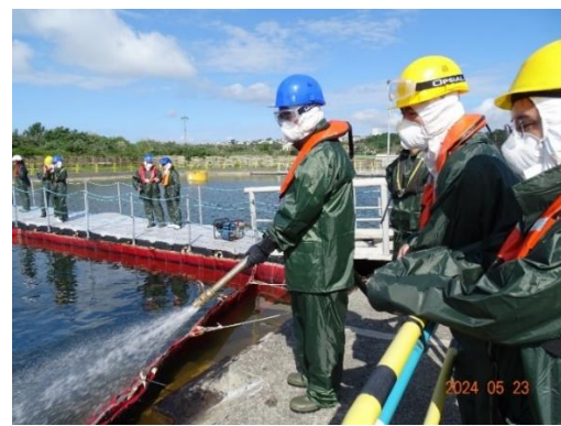
圖 3-13 集中油污以利回收作業
