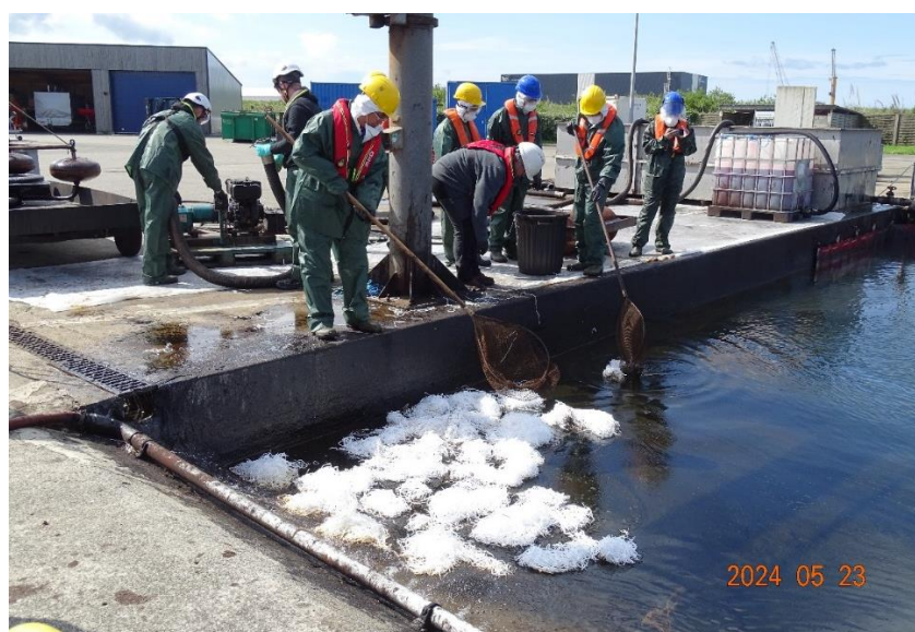
圖 3-15 使用吸附資材進行最終回收
