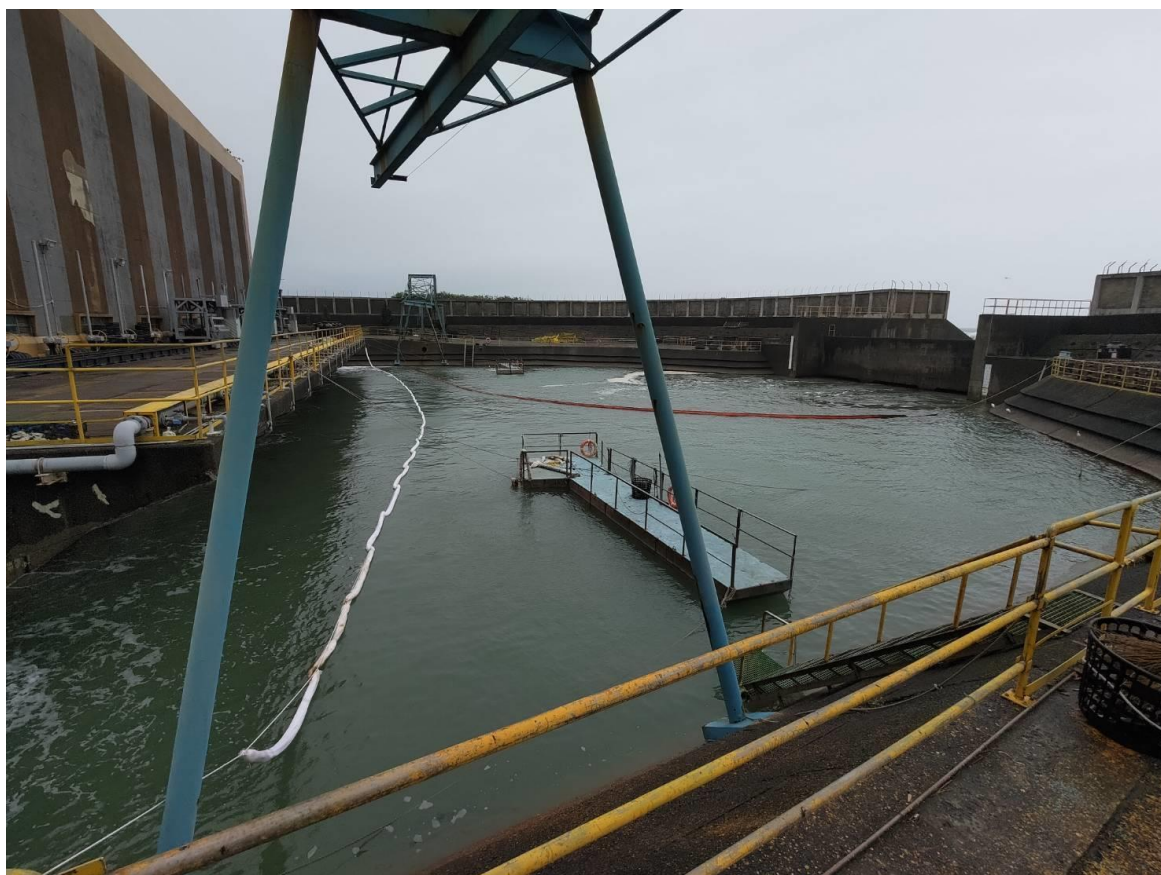
圖 3-1-67 台電核二廠抽水口預防性佈設攔油索
