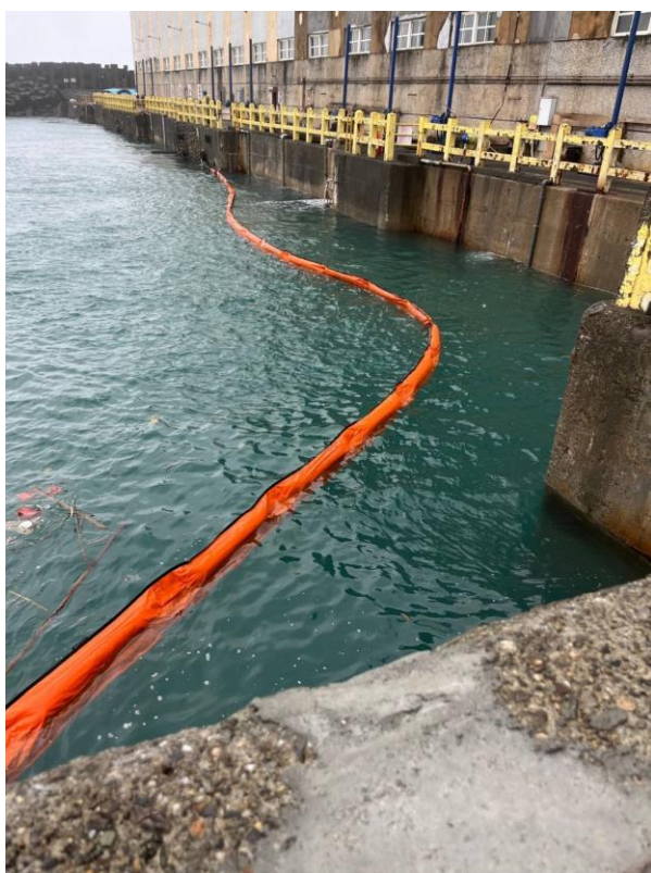
圖 3-1-69 台電協和電廠取水口預防性佈設攔油索
