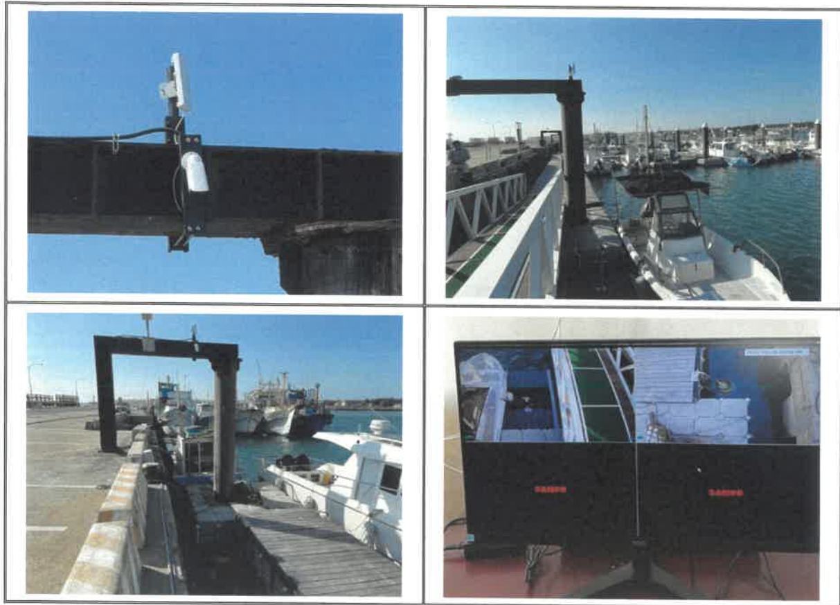
圖二、監控設備安裝情形
