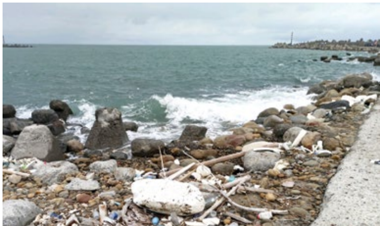
▲ 松柏漁港堤防垃圾堆積
