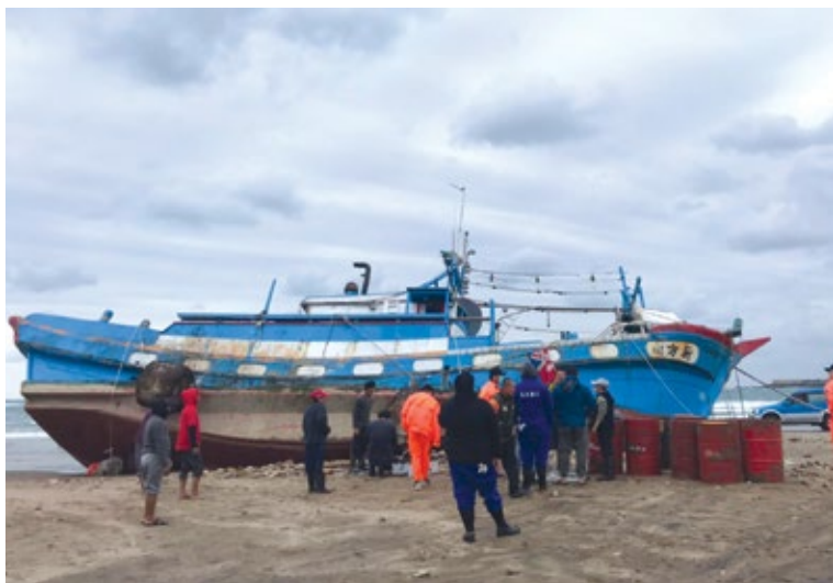
新芳壹漁船拆除前抽油作業
